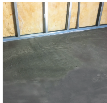
Efter 12-18 timer, når x-plan er gennemhærdet, kan vådrumsmembranen påføres og fliser monteres. Andre gulvbelægninger skal monteres efter leverandørens anvisninger.
