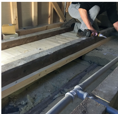
Strøer monteres på bestående bjælker og indskudsbrædder monteres på strøerne.
